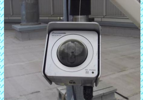
船舶レーダーのほかに複合気象装置（上図中央）と屋外カメラ（上図右）を設置しました。複合気象装置は降雨量・気温・湿度・気圧・風向・風速といった観測地点周辺の気象要素を把握する目的で設置しています。また、屋外カメラはレーダーで降雨が確認されているときの上空の雲の流れ・発達を観測する目的で設置しています。
